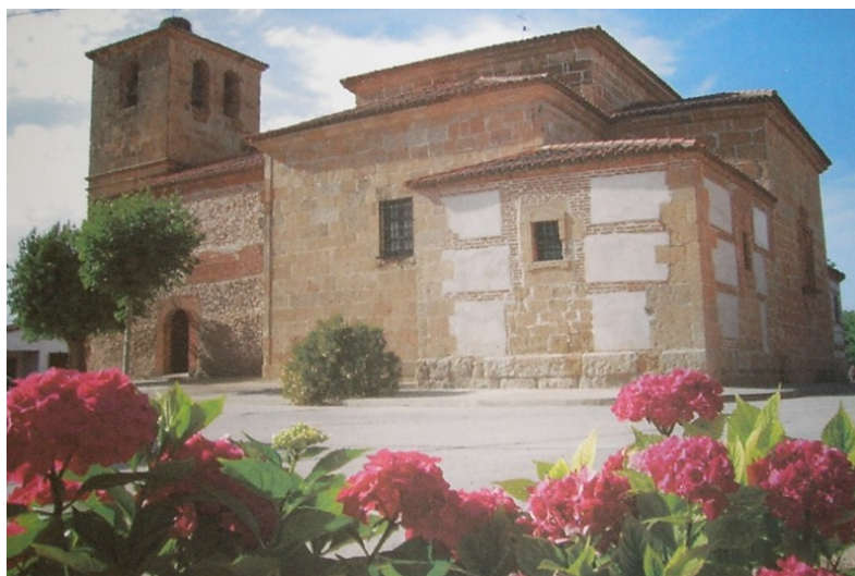
Ilustración 1. Se aprecia claramente la primitiva construcción del S-XIII a base de mampostería, la puerta de entrada en ladrillo y orientada hacia el sur o Calzada de Salamanca y los restos marcados en la pared con ladrillos, del primitivo pórtico.
